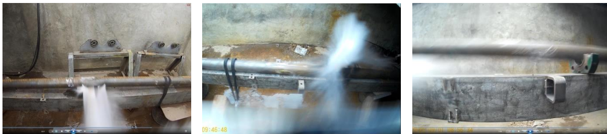
9. ábra. A statikus külső hajlítás nélkül vizsgált csővezeték szakaszok a meghibásodásuk pillanatában: a) Y3 csőszakasz, b) Y1 csőszakasz, c) Y2 csőszakasz.
